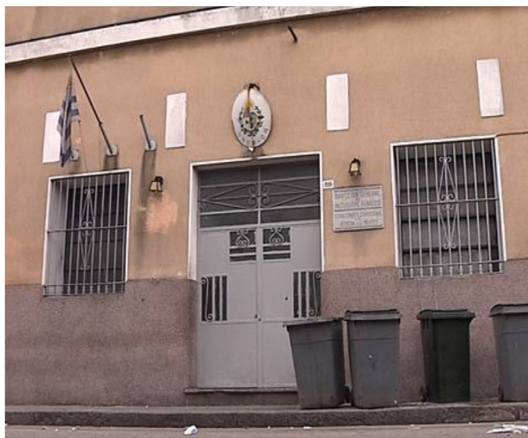
Foto 2: Frente con puerta de ingreso
